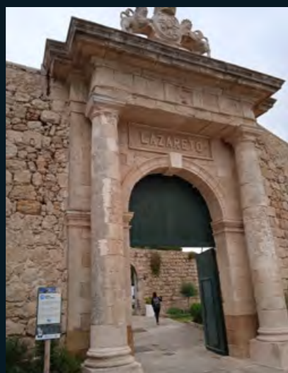
Entrada al recinto de El Lazareto.
